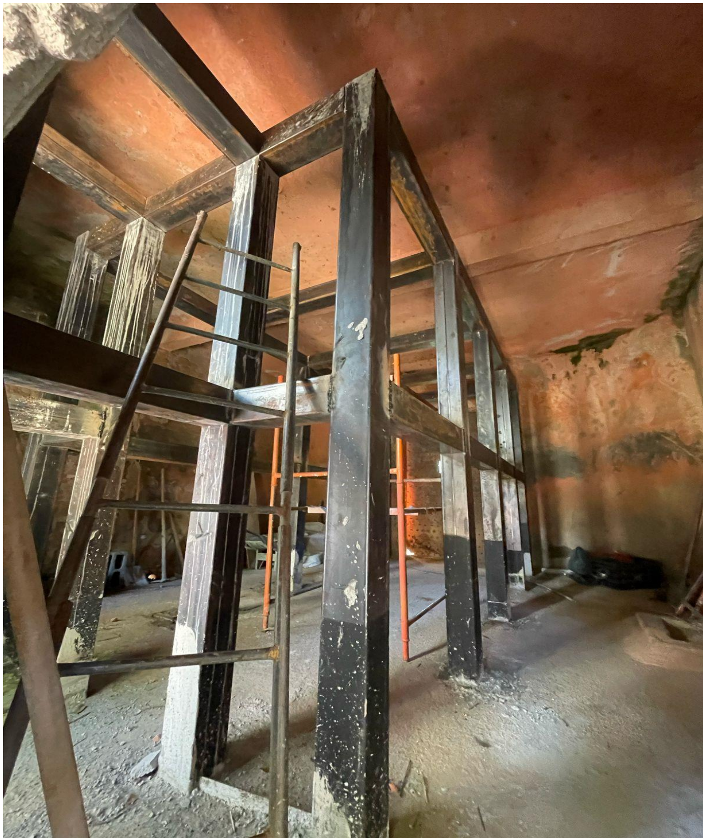
Imagem 2 – Espaço interditado devido à construção do brete (Arquivo pessoal, 2025).
